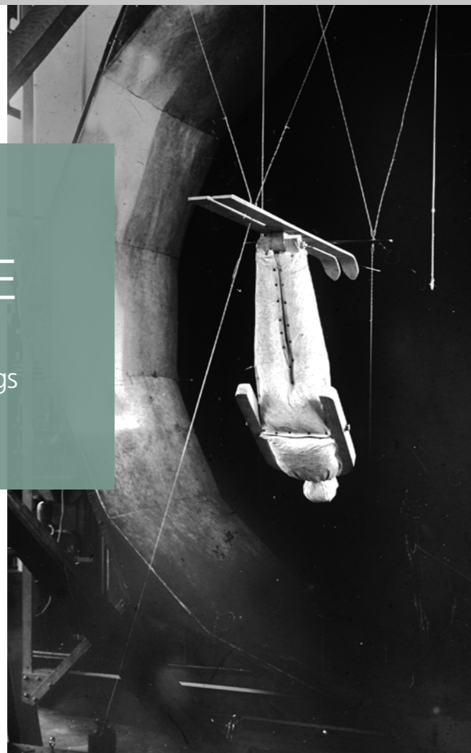
Dummy eines Skispringers im Windkanal der AVA im Jahr 1927. In den späten 1970er Jahren wurde die Untersuchung der Körperhaltung von Skispringern mit Leistungssportlern im Windkanal fortgeführt.
