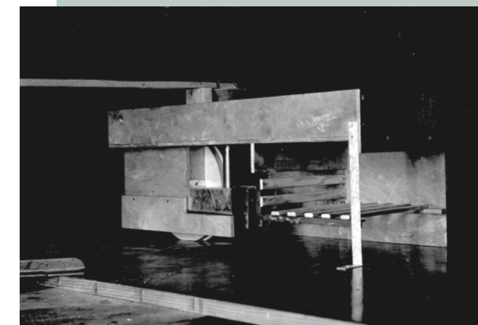
Modell einer Zugbremse für eine Straßenbahn, untersucht im Windkanal der AVA im Jahr 1928
