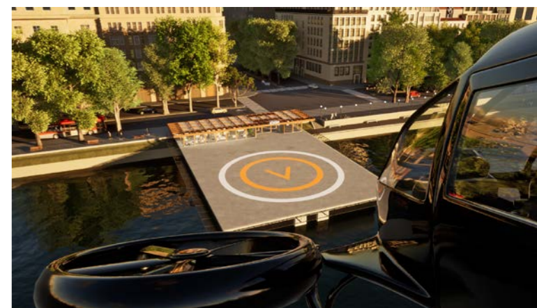
Vertiports sind die entscheidende Infrastruktur, damit in der nahen Zukunft Flugtaxis in Städten unterwegs sein können. Sie bestehen aus mehreren Landepads sowie Infrastruktur für Wartung und Reparatur. Weltweit gibt es zum Beispiel schon Prototypen in Rom, Chicago und Singapur. Ein Vertistop (unten) besteht nur aus einem Landepad.
